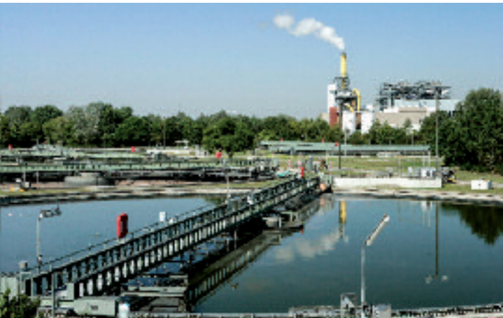
BASF-Kläranlage, Foto BASF
