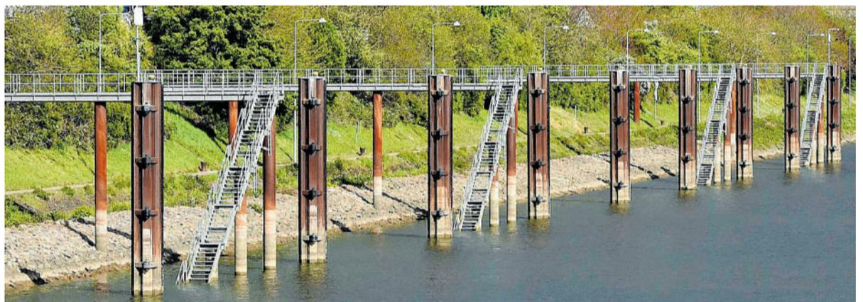
Das Museumsschiff (Bild oben) soll auf der Seite zur Fahrinne des Neckars hin mit Stahlpfeilern, sogenannten Dalben, als Rammschutz abgesichert werden. Das Bild unten zeigt ähnliche Stahlpfeiler im Neckarkanal westlich der Schleuse. BILDER: TRÖSTER
