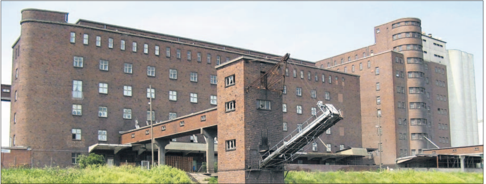
Die genossenschaftliche Burg in der Friesenheimer Straße, 1927 im Bauhaus-Stil der Neuen Sachlichkeit errichtet, steht heute unter Denkmalschutz.
