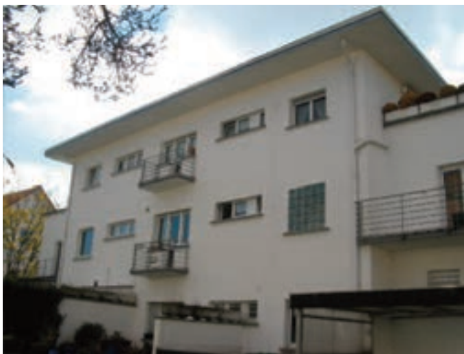
Mannheim, Mietshaus Thum/Wohnhaus Gerwig, Rückfassade, Foto 2012
