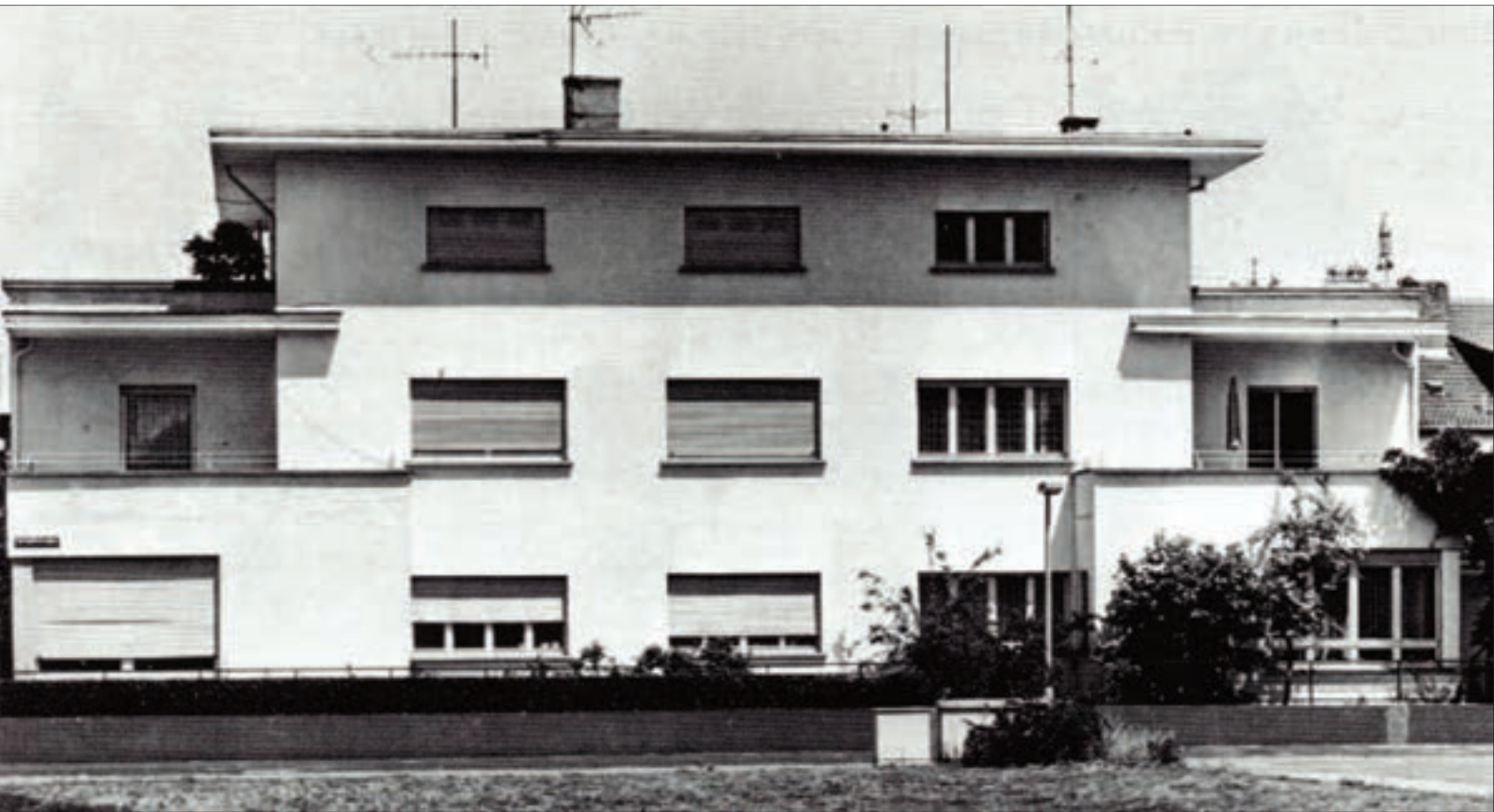
Mannheim, Mietshaus Thum/Wohnhaus Gerwig, Straßenfassade, Foto um 1980
