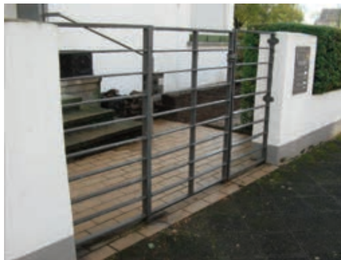
Mannheim, Mietshaus Thum/Wohnhaus Gerwig, Einfriedigung
