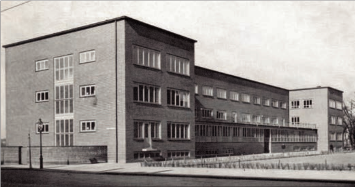
Mannheim, Mütter- und Säuglingsheim, Straßenfassade, Foto um 1930
