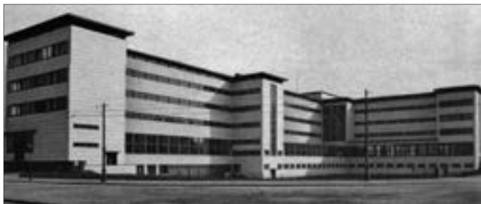
Mannheim, AOK, Südfassade, Foto um 1935
