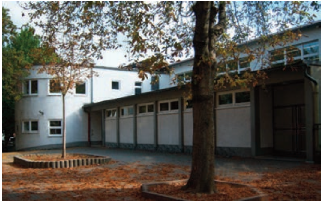
Mannheim, evangelisches Gemeindehaus Neckarau, Fassade, Foto 2009
