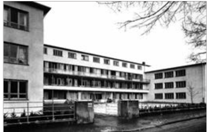
Jüdisches Altersheim, Straßenfassade nach Aufstockung des Baukörpers und Anbau von Balkonen, Foto um 1960
