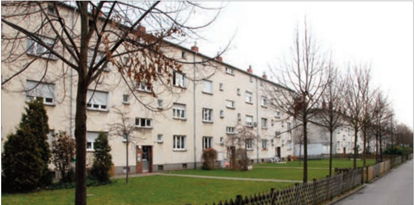
Bäckerwegsiedlung, Herxheimer Straße 1 – 25, Foto um 2010
