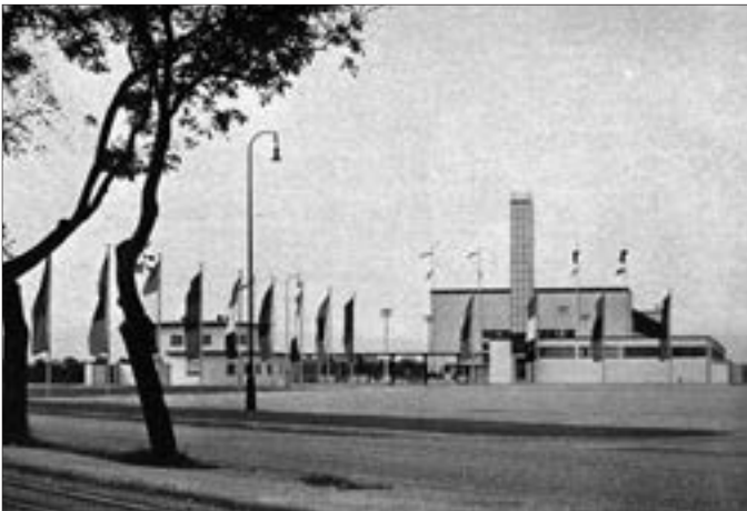
Mannheim, Rhein-Neckar-Hallen, Hauptzugang (zerstört), Foto um 1930
