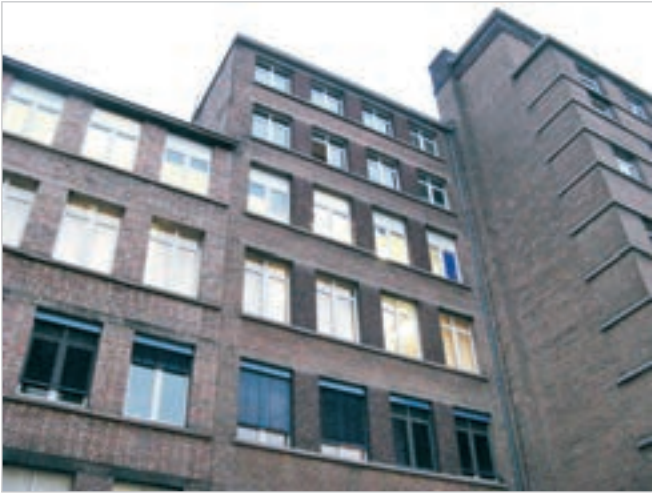
Ende der 1920er Jahre bis 1933 baute die Gründerfamilie Herbst einen modernen Flügel im Stil der „Neuen Sachlichkeit“ an. Obwohl sieben Stockwerke hoch, ist das turmartige Gebäude von der Straße aus nicht zu sehen.
