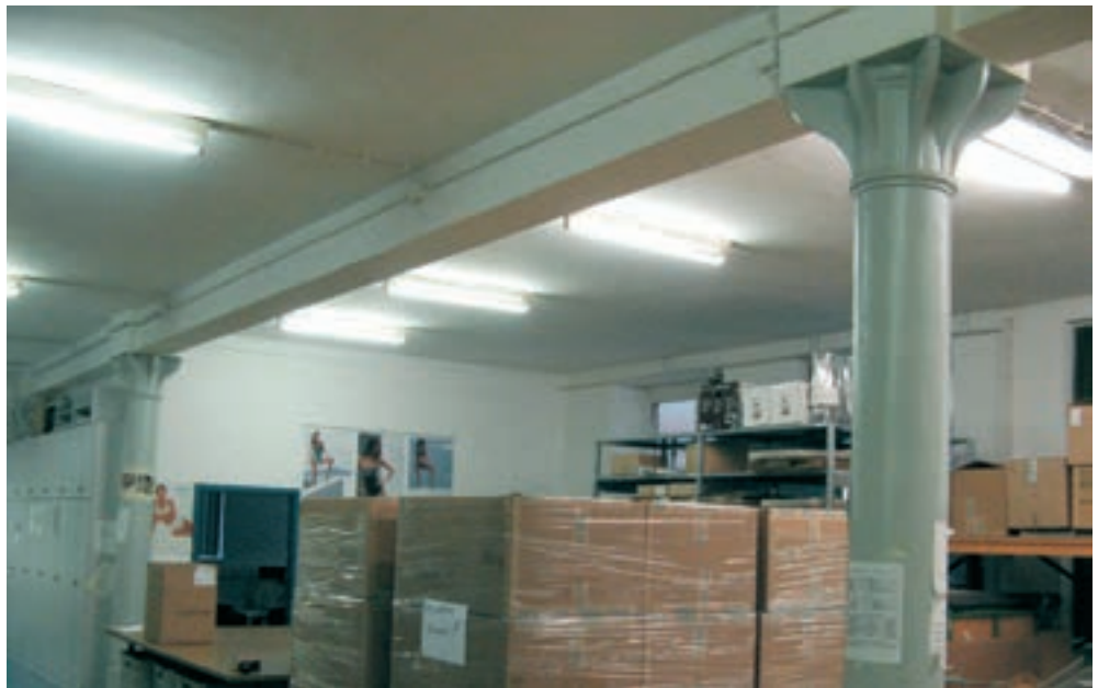
Säulen aus Gusseisen – sie existieren noch im alten Bau von 1899.
