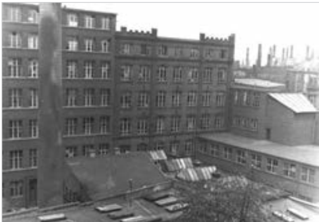
1943: Die FELINA mit ersten Kriegsschäden von der Holzbauerstraße aus gesehen. In der Mitte steht noch das älteste Gebäude mit den Dachverzierungen.
