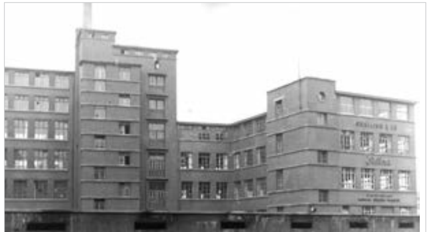
Ansicht der Felina-Fassade von 1943 von der Lange-Rötterstraße aus. Das Foto dokumentiert die vom Krieg verursachten Glasschäden. Heute ist dieser Blick nicht mehr möglich, da in den 1950er Jahren das Gebäude Ecke Melchiorstraße/Lange Rötterstraße (s. S. 6) direkt an den rechten Fassadenteil angefügt wurde.
