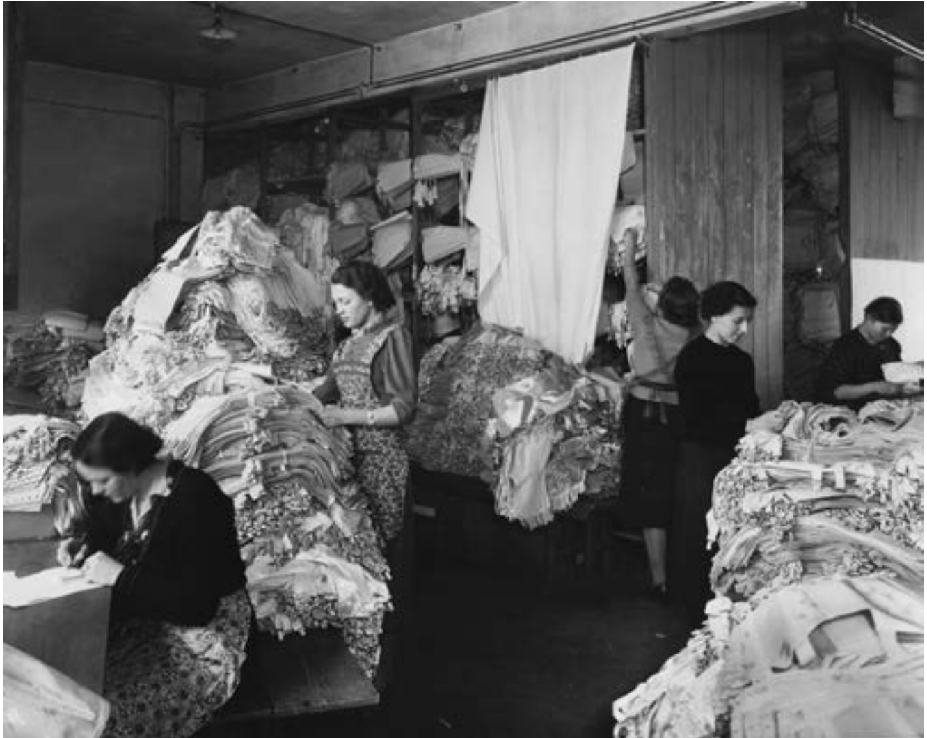
Sortieren im Fertiglager, Foto Ende der 1930er Jahre
