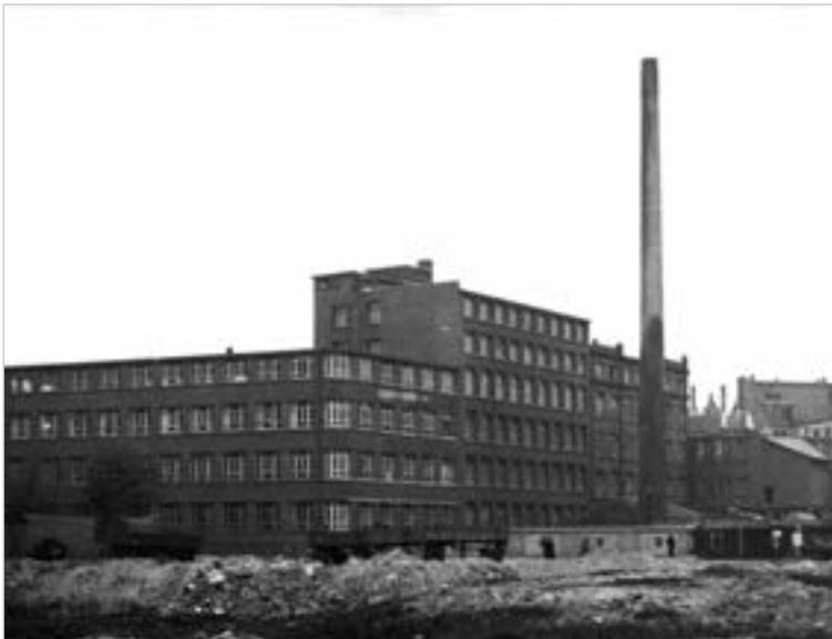
Die Neubauten der 1930er Jahre von der Melchiorstraße aus gesehen. Hinter dem Schonstein sieht man noch das alte, verzierte Flachdach des Baues von 1899.
