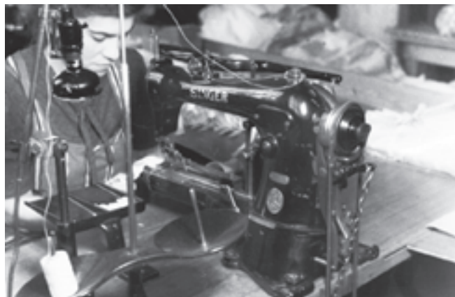
Die industrielle Fertigung von Miederwaren basiert auf einer extremen Arbeitsteilung: Hunderte von unterschiedlichen Nähten erfordern unterschiedliche Maschinen bzw. Einstellungen und Werkzeuge. Die einzelnen Arbeitsschritte wurden und werden von verschiedenen Näherinnen ausgeführt. Auf dem Foto aus den 1930er Jahren ist eine "Knopfansetz-Maschine" zu sehen.
