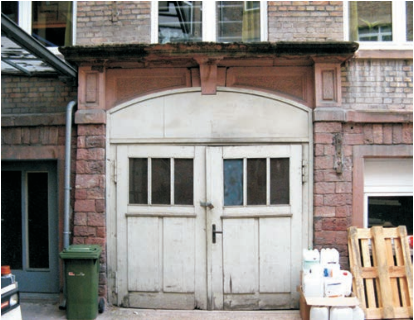
Am ältesten Gebäude der FELINA im ersten Hof ist der Sandsteinsockel im Erdgeschoss erhalten geblieben – wenn auch stellenweise stark verwittert. Das alte schmucke Sandstein-Portal steht ebenfalls noch. Es ist sogar auf der Grafik aus dem Jahr 1928 zu erkennen (s. S. 16).
