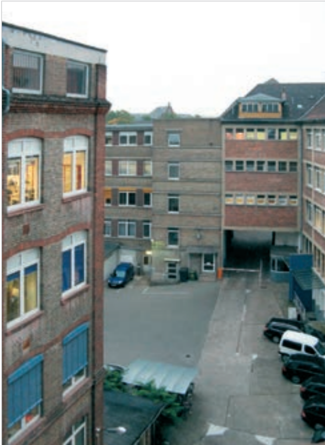
Blick aus dem Treppenhaus im Anbau von 1914 (gegenüber der Einfahrt). Hier sind alle Bauepochen auf einen Blick zu sehen: Links der ursprüngliche Bau von 1899 mit seinen charakteristischen Bogenfenstern, in der Mitte der graue Bau von 1938, rechts die Klinker- und Betonbauten von 1949.
