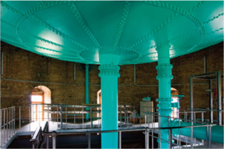
Wasserturm Friedrichsplatz, innen
