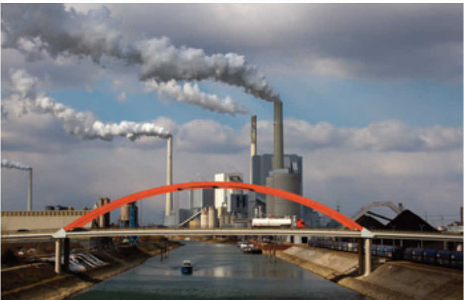
GKM mit roter Brücke
