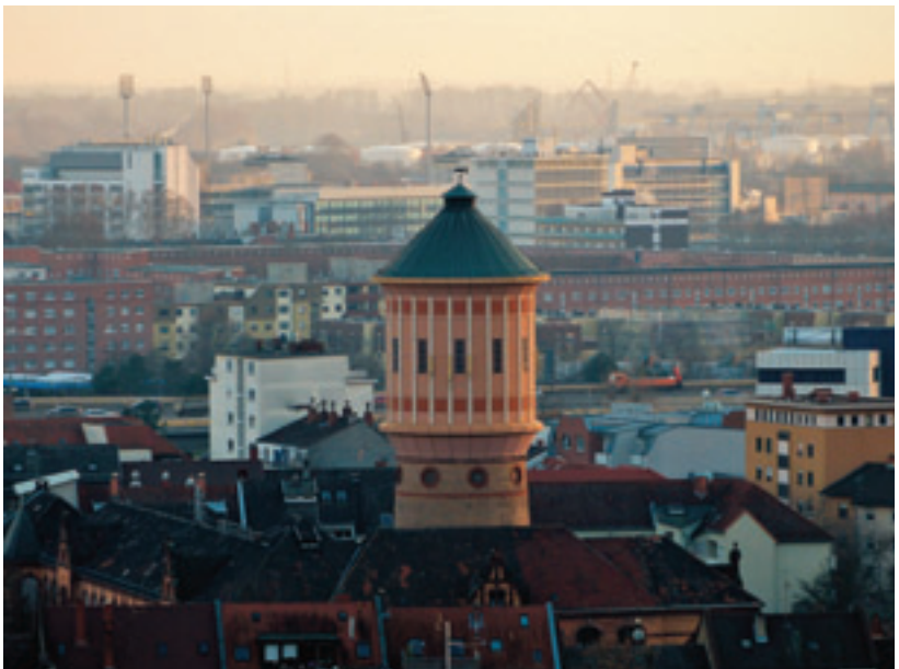
Wasserturm Gräfenau, Ludwigshafen
