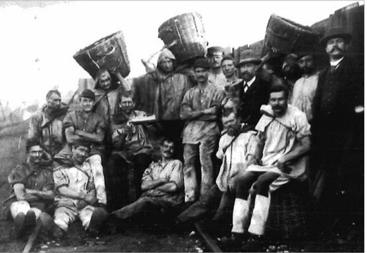
Hafenarbeiter: Das Kohlschleppen war kein leichter Weg, Geld zu verdienen. Mannheimer Hafenarbeiter mit Anwerbern um 1890. Foto aus: Nieß, Ulrich/Caroli, Michael (Hg): Geschichte der Stadt Mannheim, Bd. 2, Heidelberg, 2007–2009.
