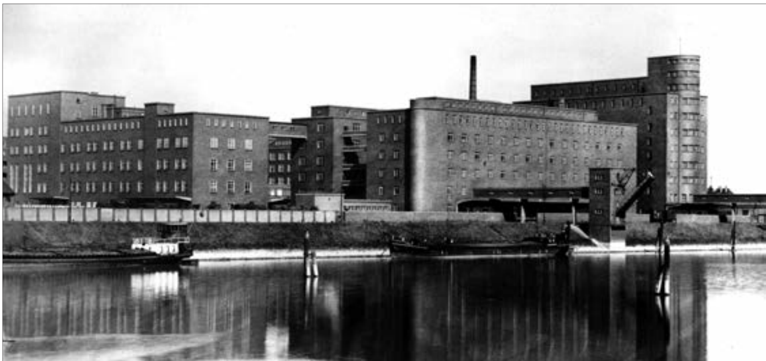
Blick vom Industriefhafen auf die GEG-Betriebe im Jahr 1954. Erst später wurden Betonsilos rechts an die Mühle angebaut.
