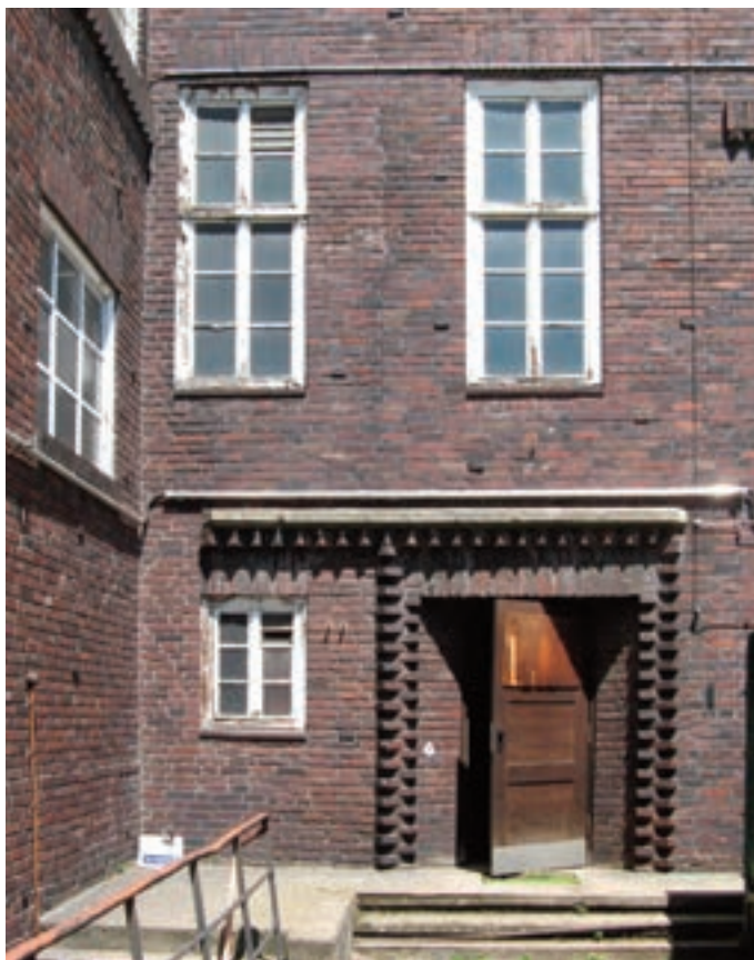
Architektur des Neuen Bauens der Weimarer Zeit prägt das Gebäude. Dunkelrot bis blau ist die Klinkerfont mit einzelnen herausragenden Steinen und einem spielerisch gemauerten Fries um die einfachen Türen.
