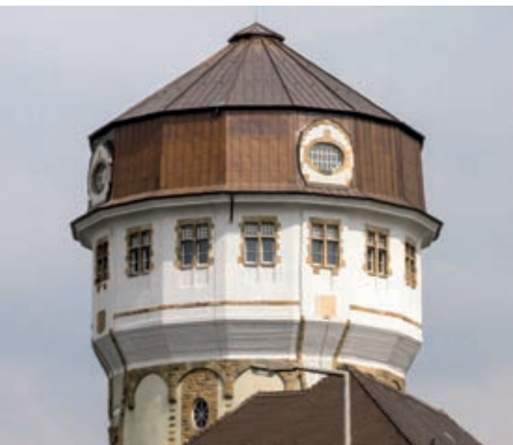
Luzenbergwasserturm, Foto Barbara Ritter
