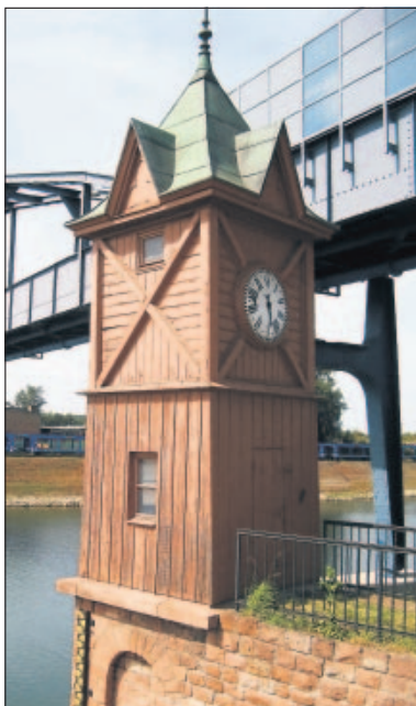
Das Pegelhäuschen in Rheinau und...
