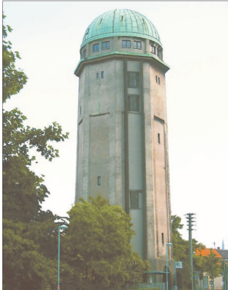
Der Seckenheimer Wasserturm wird bald in neuem Glanz erstrahlen.
