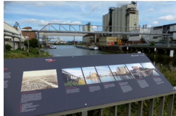
Panoramapunkt P4: Eine Kammerschleuse verbindet den Industriehafen mit dem Neckar, der wenige hundert Meter weiter in den Rhein mündet. Von hier hat man eine interessante Aussicht auf etliche bedeutende und traditionsreiche Industriebetriebe. Im Hintergrund die Ölmühle Bunge mit ihrem Rohrleitungslabyrinth, den vielen großen Silos und – von hier gut sichtbar – dem architektonisch interessanten Silogebäude im Stil der neuen Sachlichkeit aus dem Jahr 1929 (Standort: an der Kammerschleuse).
