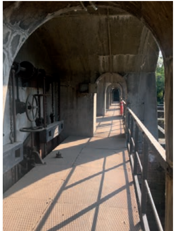
Schleusenarkade im Zulaufbereich
