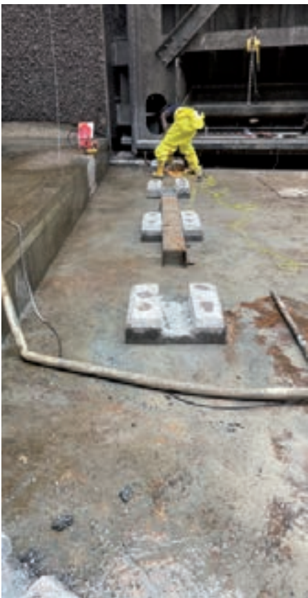
Tieferlegung der Luftsprudelleitung
