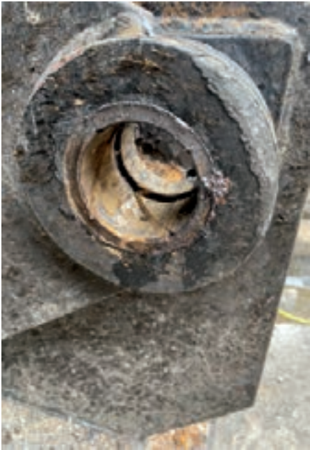
Die beanspruchten Bolzen an den Schützklappen wurden ersetzt.
