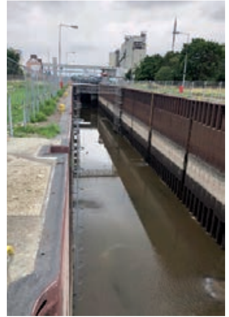
Die Revisionsarbeiten wurden durch die starken Regenfälle und das Druckwasser erschwert.
