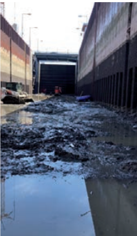
Wie immer war außer dem üblichen Schlamm viel Unrat aus der Schleusenammer zu entfernen.
