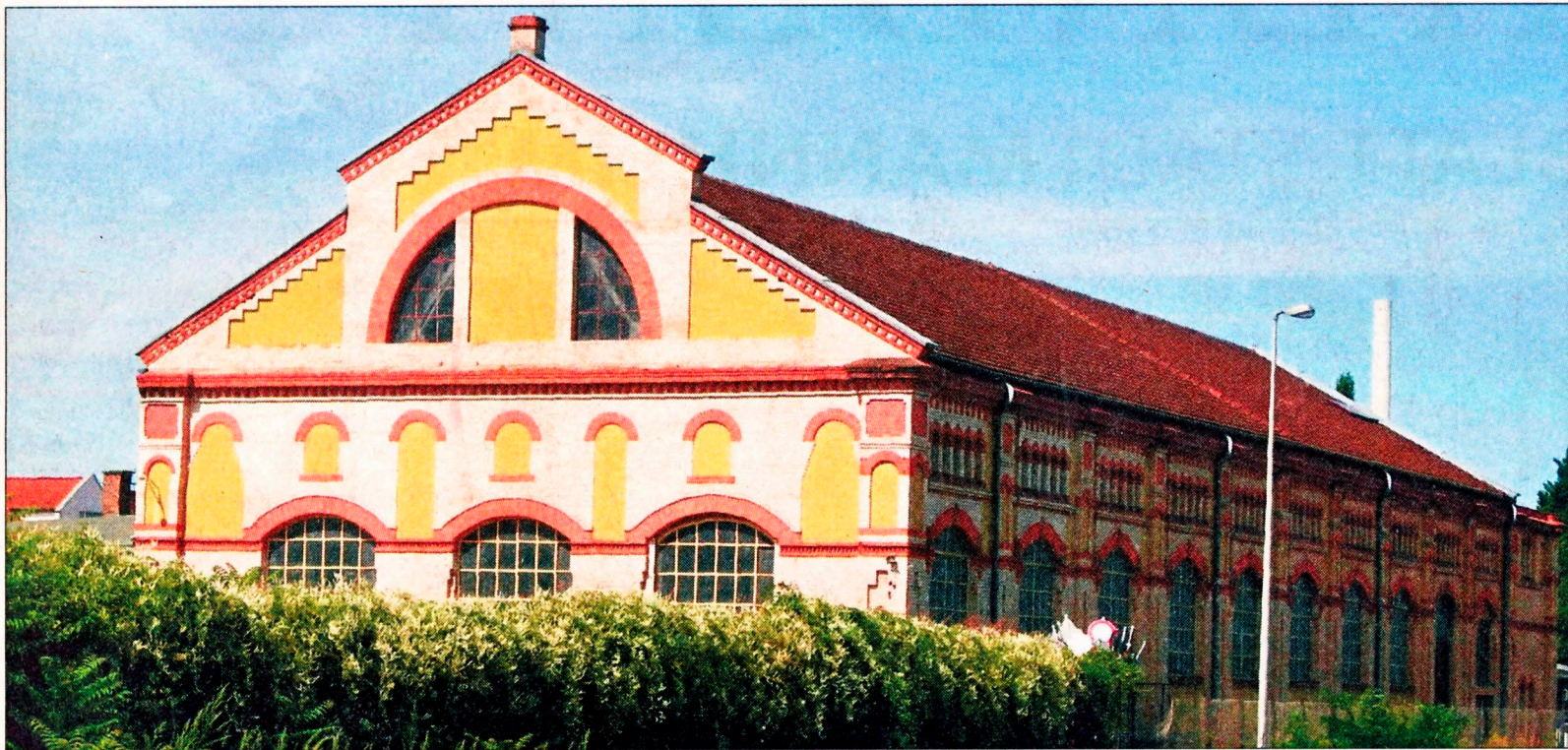
Ein architektonischer Zeitzeuge: Das E-Werk in Mannheim-Rheinau gelegen an der Rhenaniastraße.
